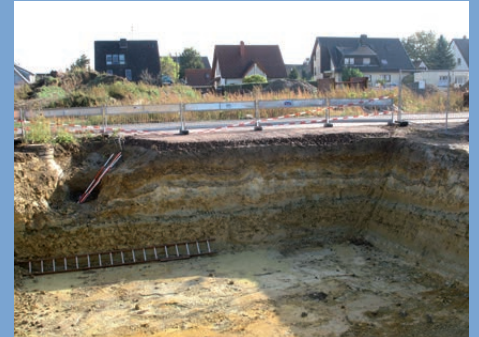
Der Untergrund ist bunt: Baugrube in Gottenheim Le sous-sol a des couleurs: fouille à Gottenheim (Bildquelle/Source: Nitsch/LGRB)
